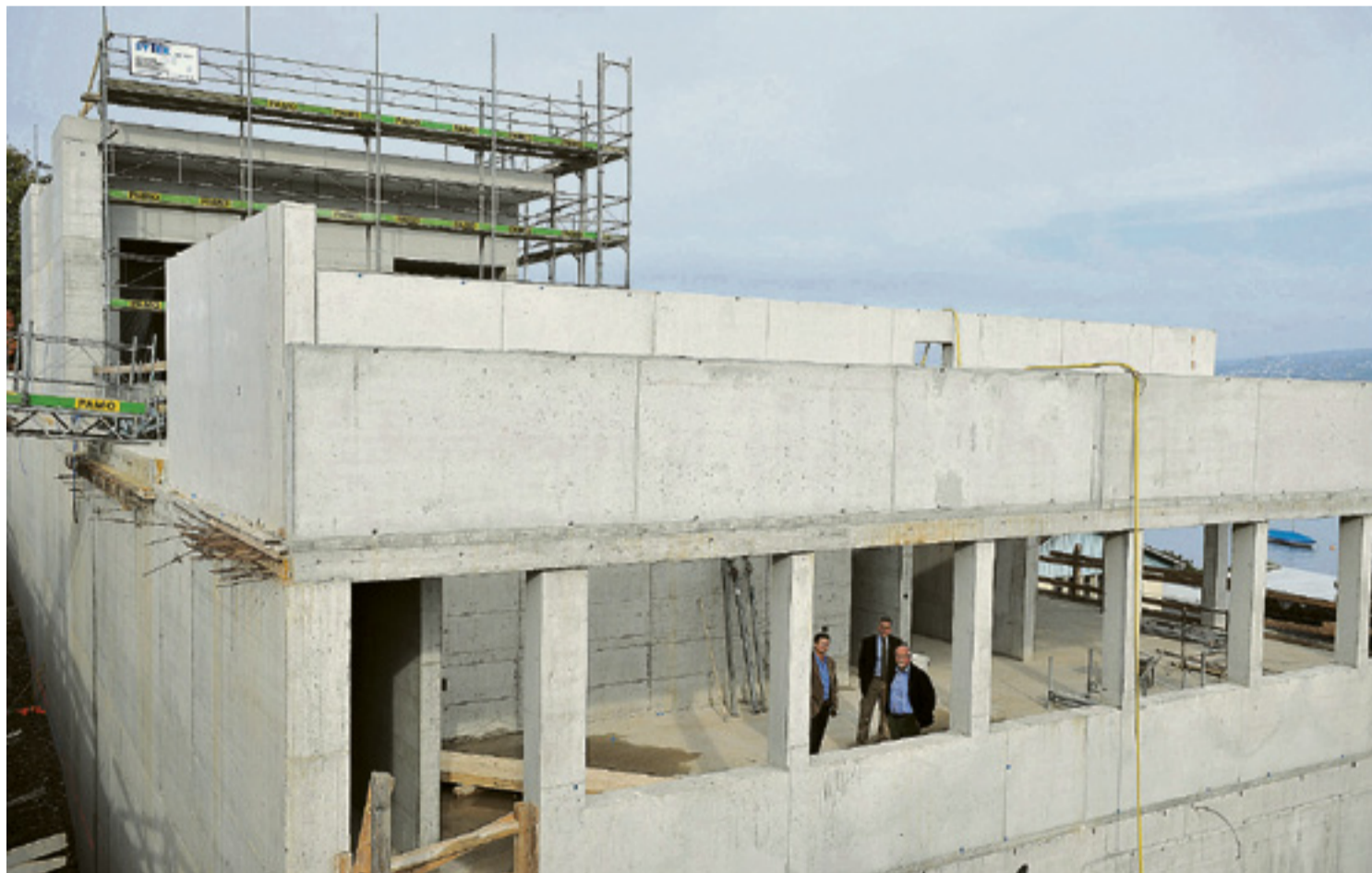
22 Meter hoch ragt der Betonbau empor. Im September 2012 soll das neue Werk eröffnet werden. Bild: Manuela Matt
