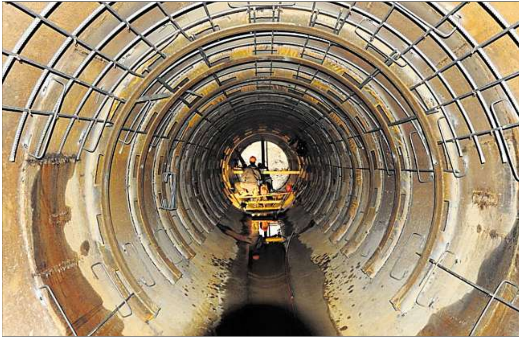
Ein Arbeiter im rund 2,5 Meter hohen Tunnel unter der Bahnlinie. (zvg)
