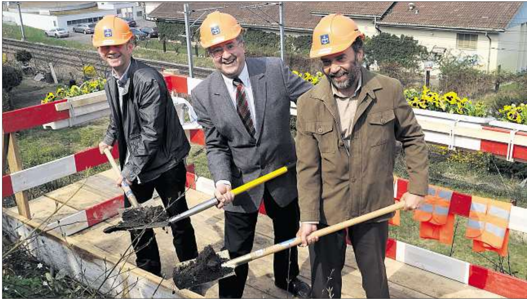
Der Horgner Gemeinderat und Präsident ad interim der Betriebskommission, Theo Leuthold (Mitte), beim Spatenstich für das neue Seewasserwerk Hirsacker; er wird flankiert von Architekt Andreas Felber (links) sowie Bauleiter Christoph Meier. Im Hintergrund das alte Seewasserwerk an der Hirsackerstrasse. (André Springer)
