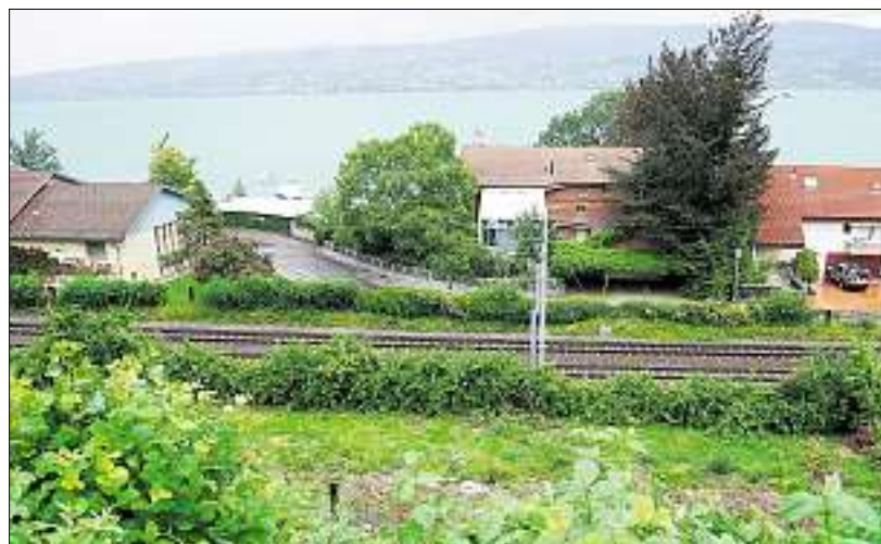
Neuer Standort des Seewasserwerks ist die Parzelle südlich des bestehenden Werkes zwischen Bahngleis und Seestrasse. (Nina Frey)
