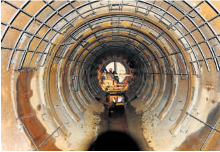
22 Meter lang ist das Rohr, welches das Seewasserwerk mit dem See verbindet. Foto: PD
